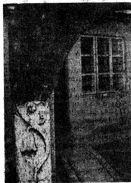
17 Detaliu de ușă, casa de la Gălățeni (jud. Harghita)
