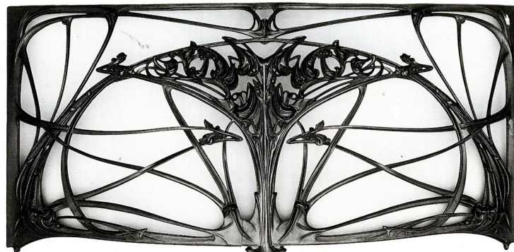
Ill. 9 : Panneau central de grand balcon. Exécuté par les Fonderies de Saint-Dizier (Haute-Marne). Fonte, 0,810 x 1,730 m. Modèle utilisé par Guimard au 8, rue Agar à Paris. Philippe Thiébaud, Marie-Laure Crosnier Leconte, Guimard, Paris, RMN, 1992, p. 319, fig. 16
