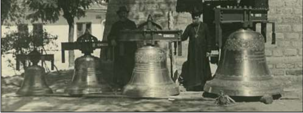
Cele patru clopote ale Episcopiei Maramureșului înainte de a fi instalate
