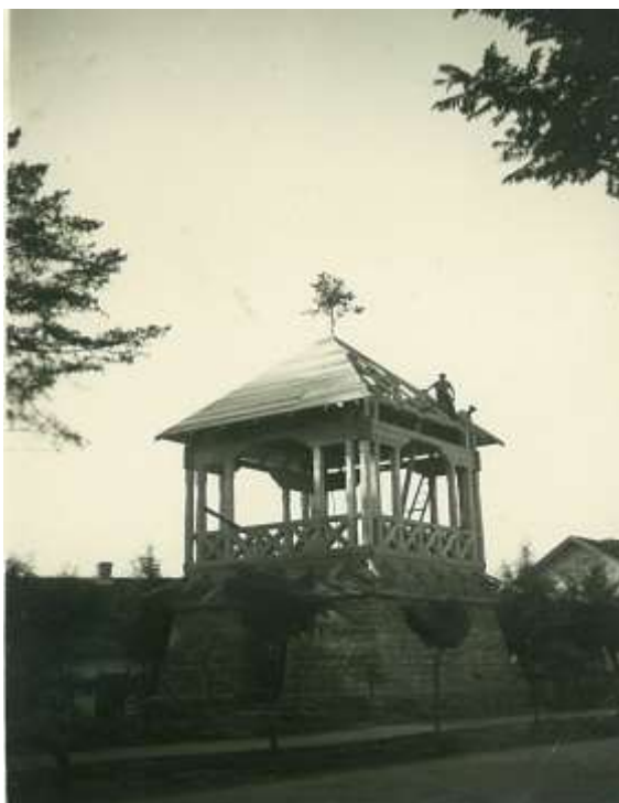
Clopotnița în timpul construcției. În vârful construcției poate fi observat „struțul maramureșean”.
