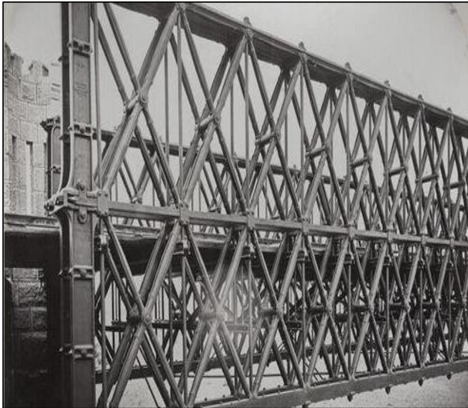
Podul de cale ferată de peste Prut, construit după metoda lui Rudolf Schifkorn.
