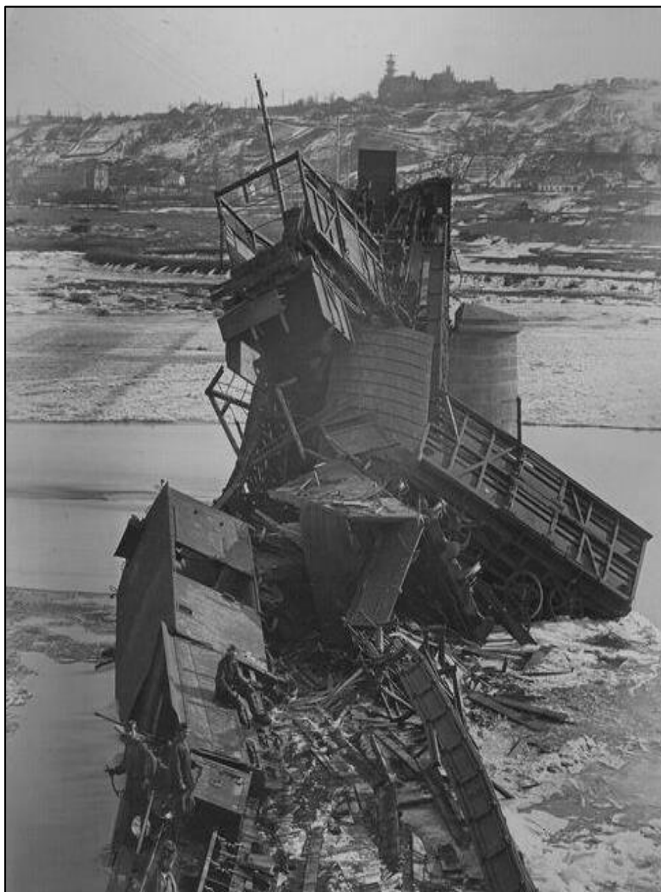
Podul de cale ferată de peste Prut, după prăbușire.
