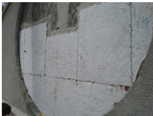
Etapă intermediară de montare
