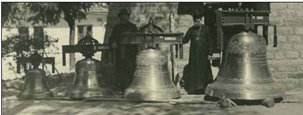
Cele patru clopote ale Episcopiei Maramureșului înainte de a fi instalate
