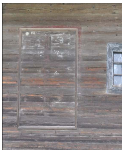
Sf. Cruce din zona pronaosului, perete sudic.
