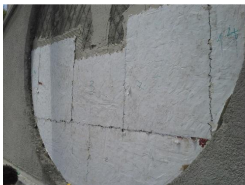
Etapă intermediară de montare
