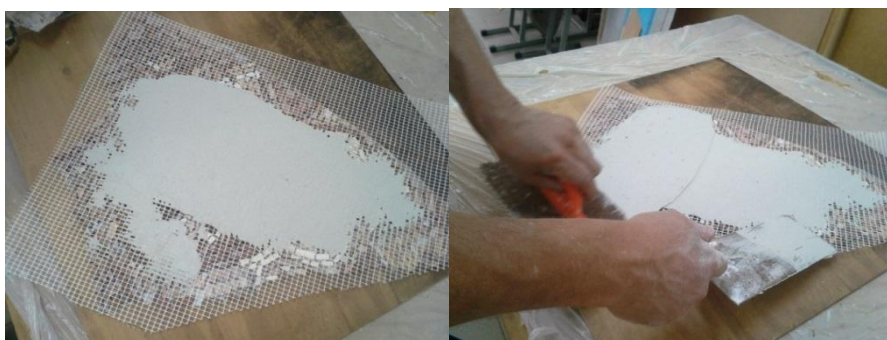
Lipirea adezivului și a plasei pe spatele plăcilor de mozaic
